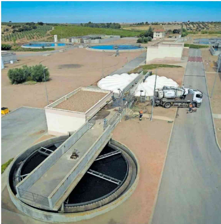
Estación de aguas residuales de Almendralejo (Badajoz), en septiembre de 2022. PACO PUENTES
