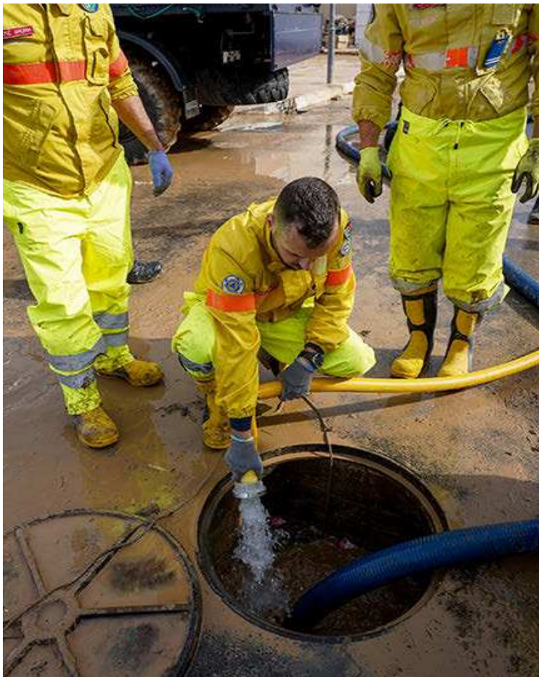
El sistema de saneamiento aún no se ha recuperado por completo. Europa Press
