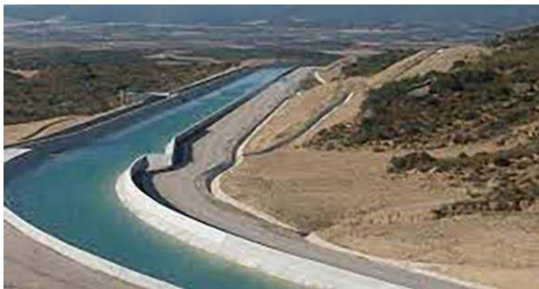
A principios de abril se inauguraron las obras de ampliación de la primera fase. Canasa
